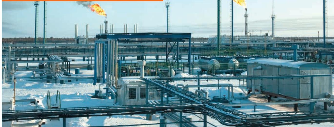
Газовые компрессорные станции применяются в нефтегазодобывающей промышленности в следующих областях: сбор и транспортировка ПНГ для переработки в промысловых установках или на ГПЗ; сжатие ПНГ, подаваемого в газотурбинные агрегаты, вырабатывающие электроэнергию; газлифтная добыча нефти; закачка ПНГ в пласт для повышения нефтеотдачи или временного хранения газа.
